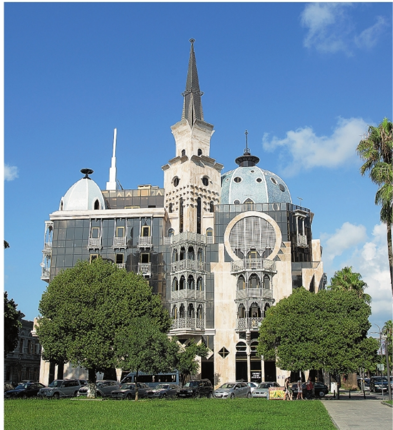
ბათუმი. სახლი გუმბათით. ფასადი BATUMI. HOUSE WITH DOME. FACADE
